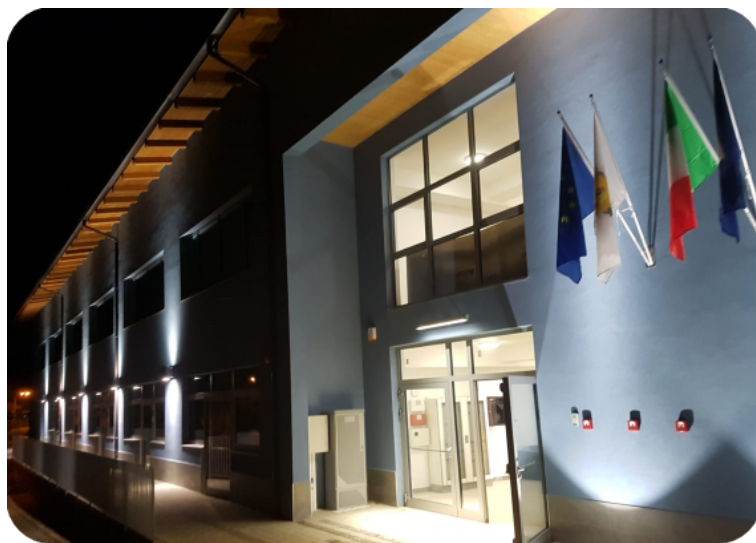
Fig. 1- Ingresso della nuova sede
